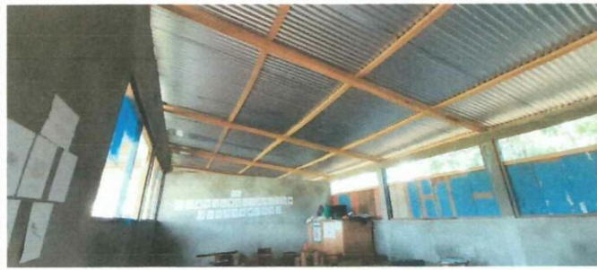
Foto 3: SUSTITUCION DE REGLAS DE MADRE POR COSTANERAS
